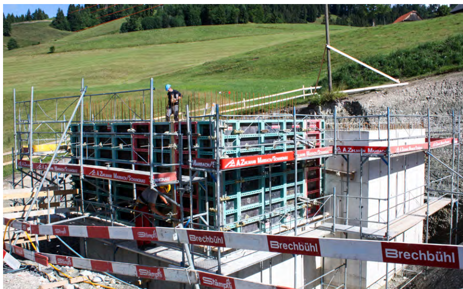
Abb. 1: Neubau Reservoir Längschwand.
