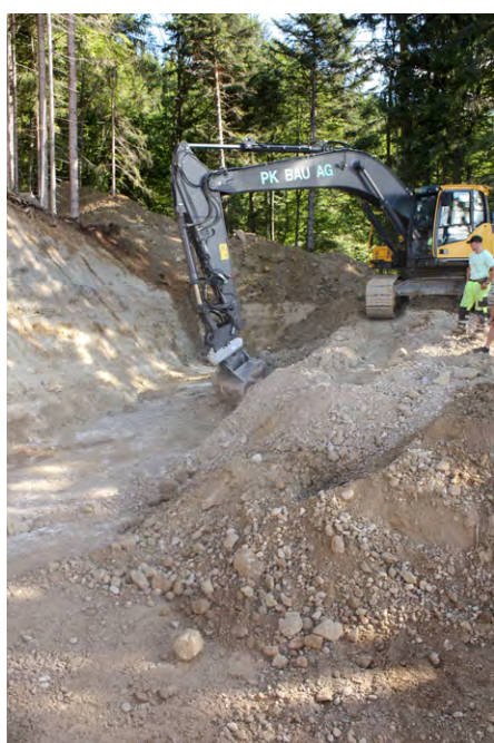
Abb. 2: Vorbereitungsarbeiten für Standort Reservoir Chnubelsegg.
