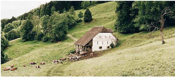
Abb. 2: Den denkmalgerechten Erhalt sicherstellen (Feldscheune bei Langenbruck BL). Dank ihrer einfachen Bauweise und den verwendeten lokalen Materialien lassen sich traditionelle Nutzbauten mit bescheidenen Mitteln erhalten. Die Landwirtschafts- und Landschaftspolitik muss dieses zumeist private Engagement ganzheitlich unterstützen.
