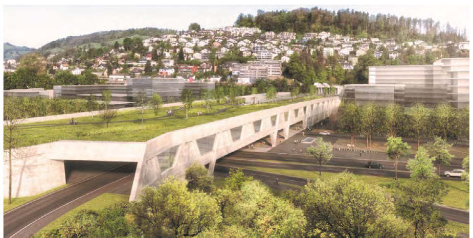
Abb. 7: Überdeckung des Tunnelportals des neuen Autobahnbypasses.
