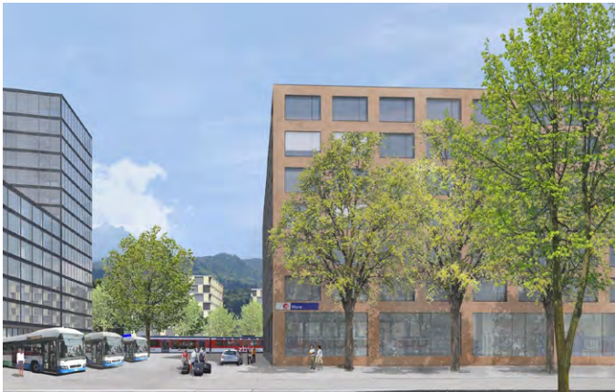
Abb. 4: Bushub Bahnhof Horw.
