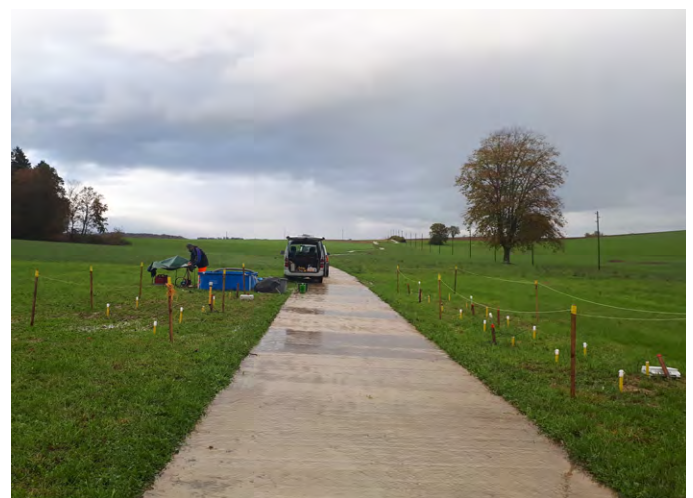
Fig. 3: Chemin en dalles de béton. Les écoulements de surface franchissant le chemin au niveau des barrages sont bien visibles (photo: E. Berdat).
