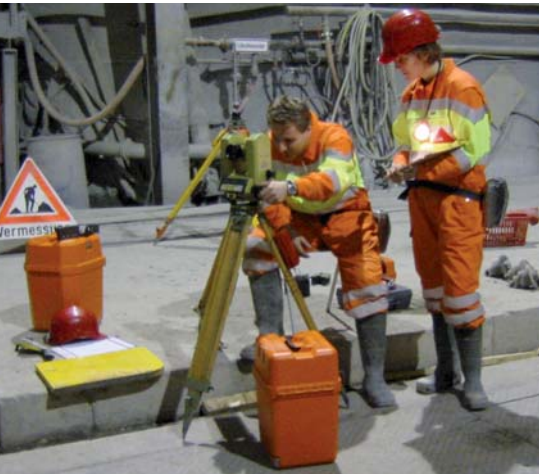
Abb. 5: Theodolit-Standpunkt in der Schachtfusskaverne.
